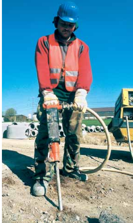
Arbeiter an einem Presslufthammer (Bildarchiv HVBG)
