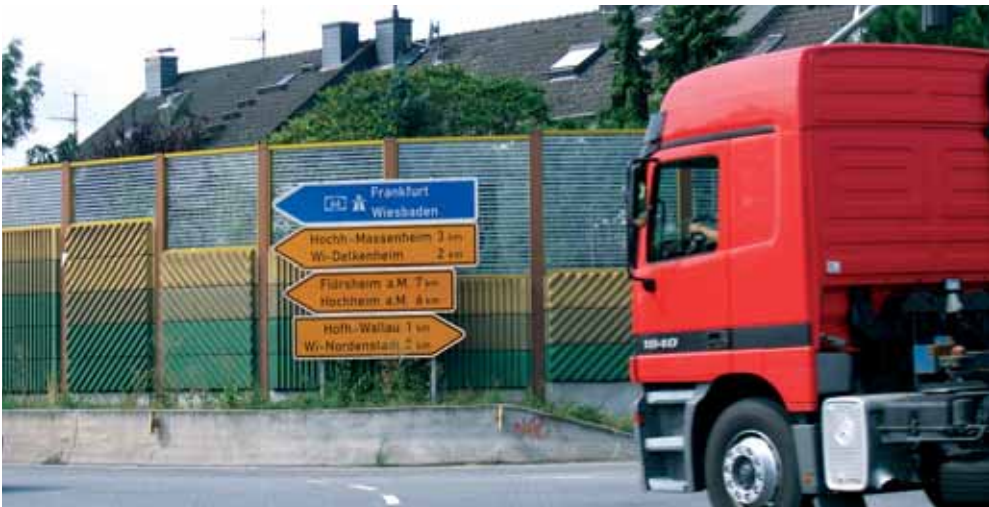
Schallschutz an einer Straßenkreuzung in Hofheim (Foto: Gunther Möller)
